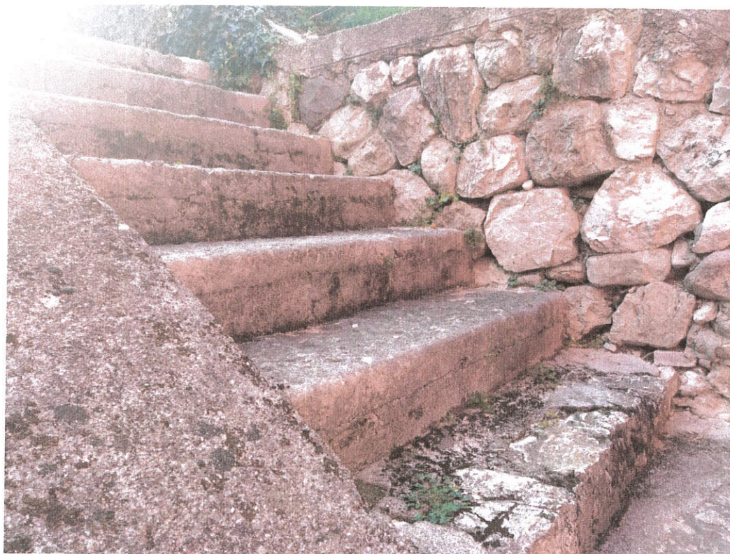
Scala esterna che conduce al Piano Primo
